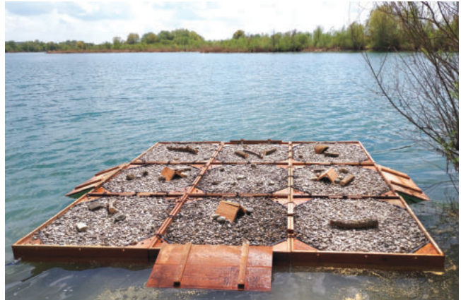
Das Brutfloß wurde vor Ort aus den einzelnen Modulen zusammengebaut. (N. Alt)
